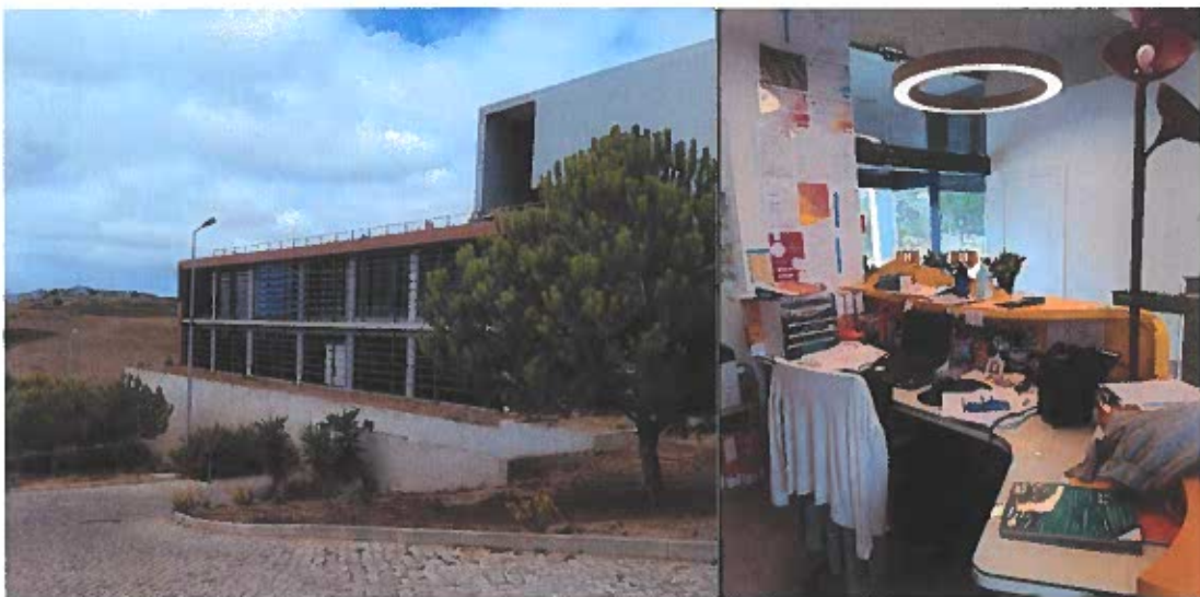
Fachada lateral com janelas para espaços de formação e balcão secretariado na entrada
